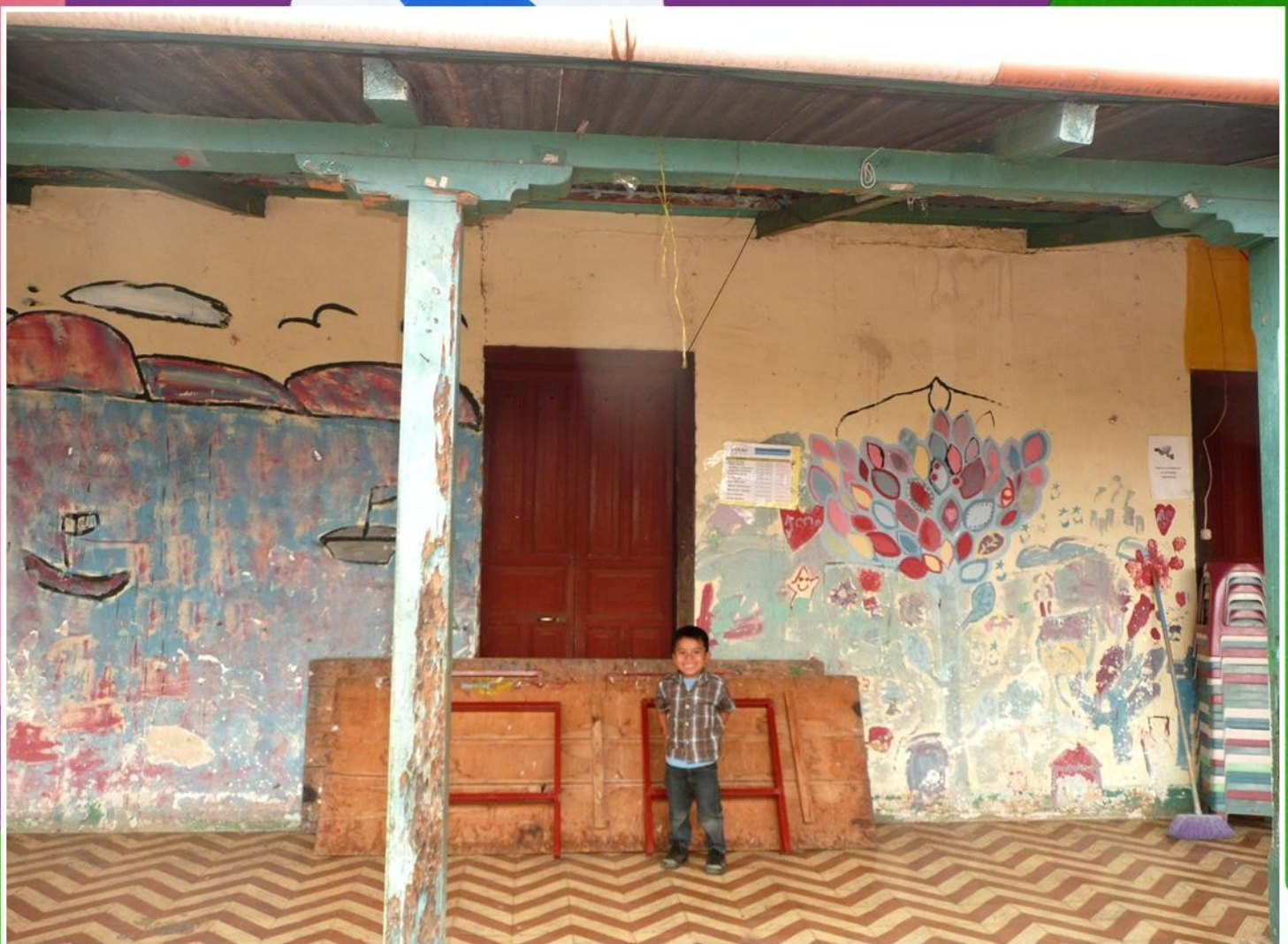
Het KDV vóór de werkzaamheden.
